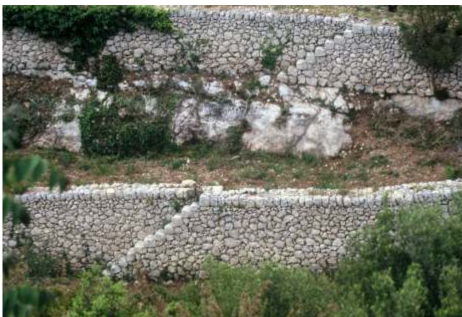
San Corrado Fuori Mura - Terrazzamenti
